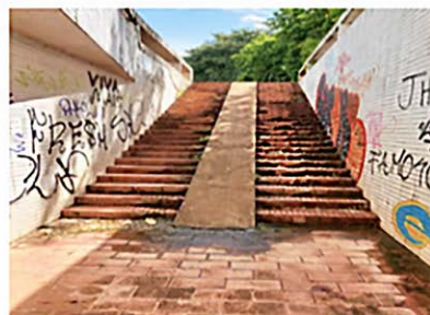
Foto 5 : escada de acesso à passarela Revestimentos degradados
