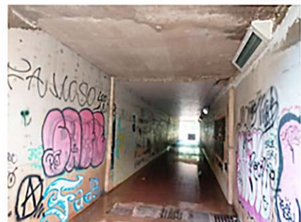
Foto 6: túnel da passarela Revestimentos degradados pela ação do tempo e vândalos
