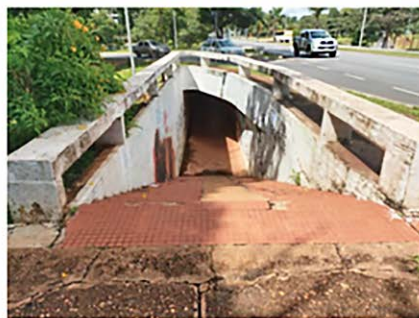
Foto 3: escada de acesso à passarela Falta de guarda corpo e corrimão
